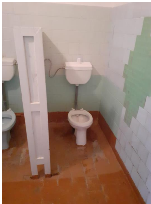
Туалетная комната Фото № 14
