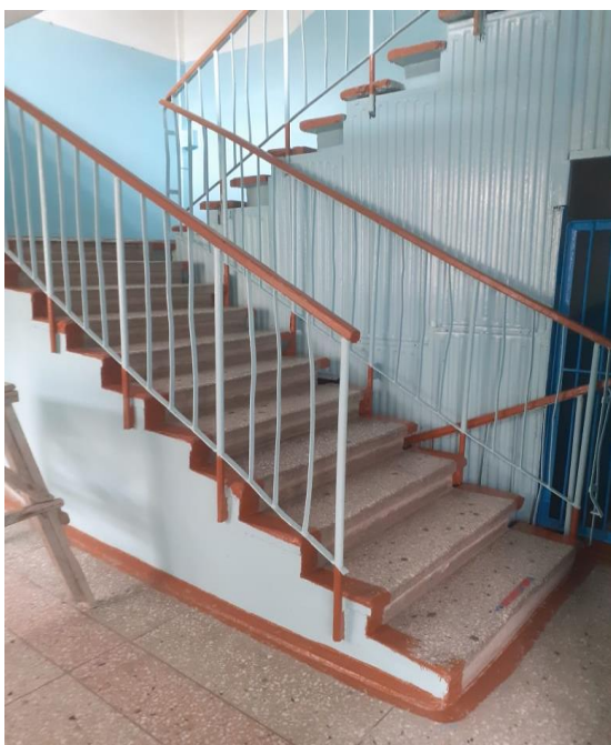
Лестница внутри здания Фото №19
