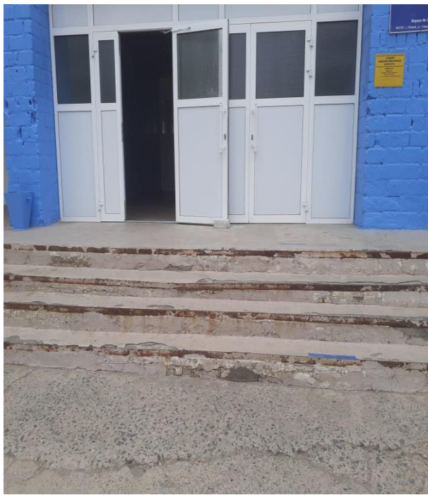
Лестница наружная Фото № 3
