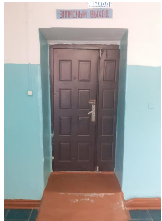
Пути эвакуации Фото № 12
