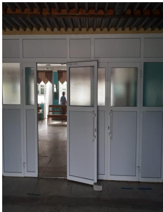
Дверь (входная) Фото № 6
